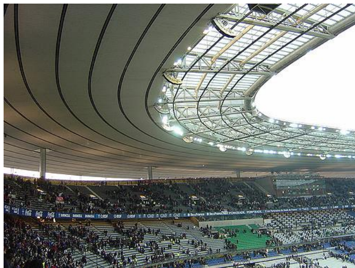
Figure 30 : L'utilisation de la laine de roche dans la toiture du stade de France
