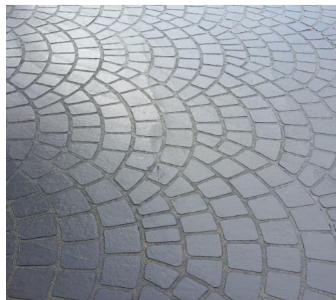
Figure 125 : revêtement en béton matricé coloré
