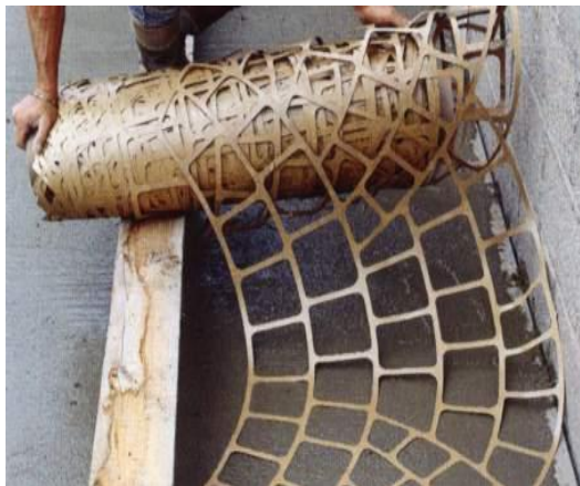
Figure 124 : matrice pour le coulage
