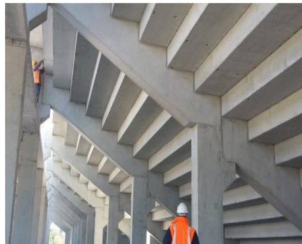
Figure 84 : un tribune en béton
