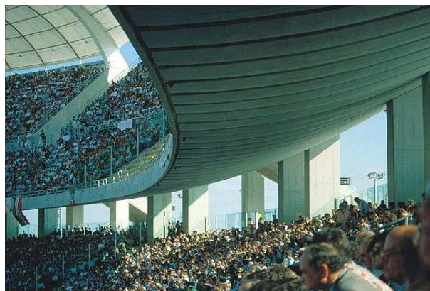
Figure 29 : Ouvertures au niveau de l'enceinte assurant le confort thermique dans le stade
