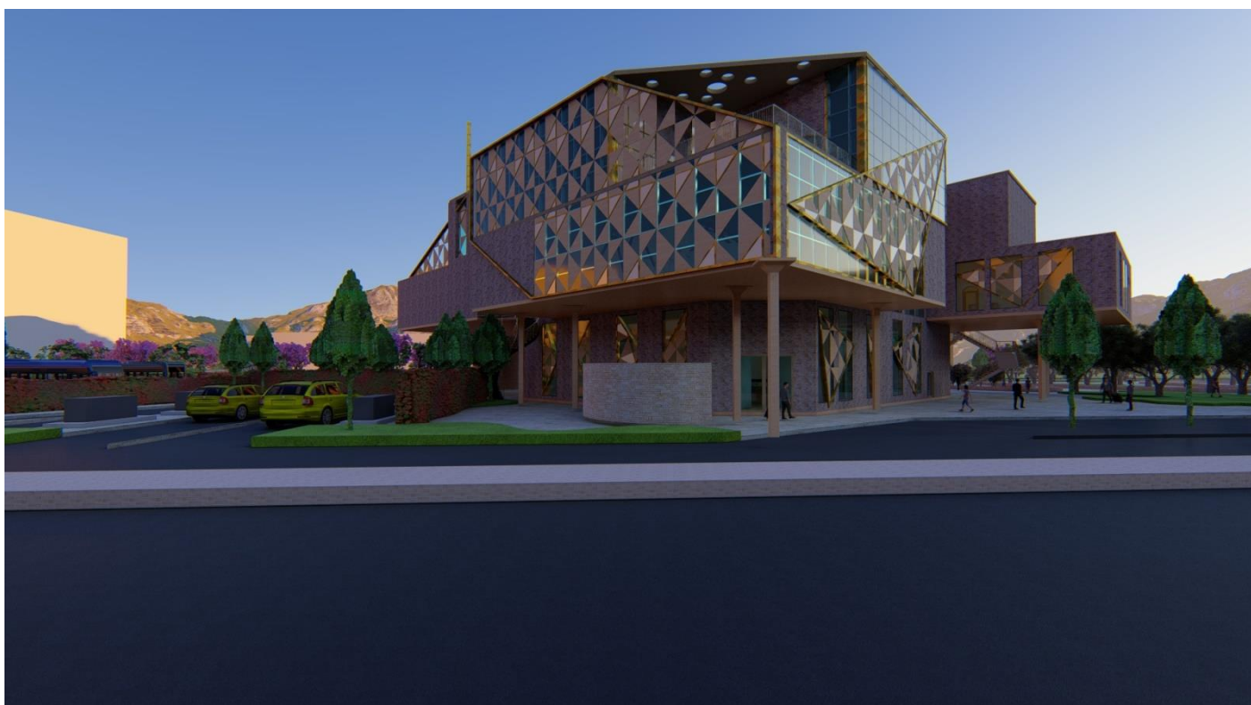
Entrée principale du Bloc A
