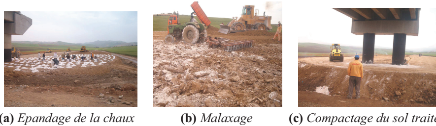
Figure 6. Opérations d'épandage, de malaxage et de compactage
