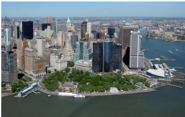
Figure 6 : Aménagement côtier résilient intégrant infrastructures de protection (bermes, murs anti-inondation) et paysage urbain – East Side Coastal Resiliency Project, New York.
