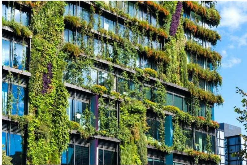
Photo 11 : Batiment de l'éco-construction
