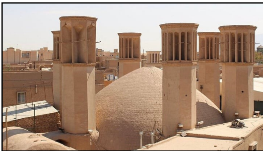
Photo 7 : Tour à vent
