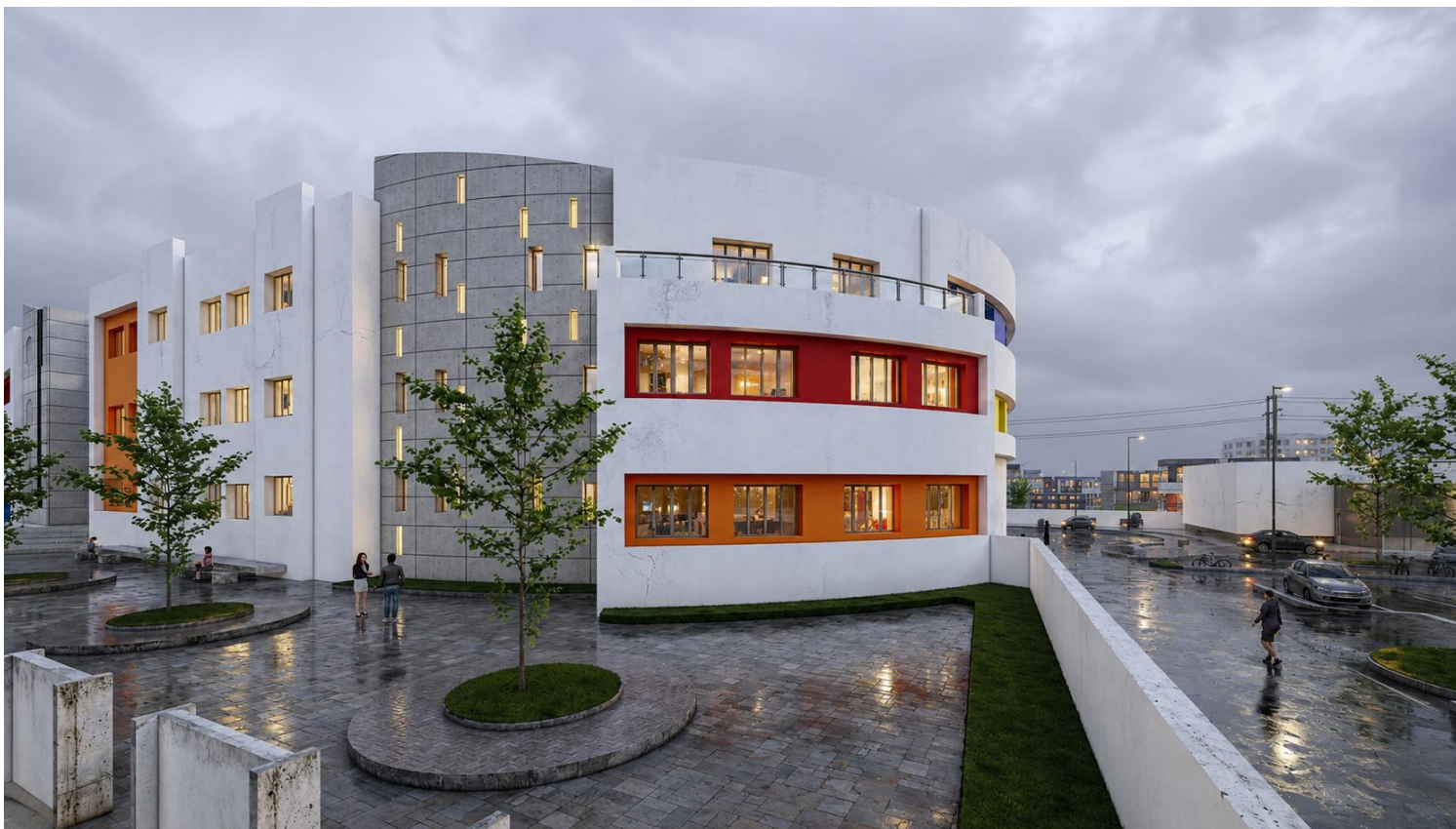
VUE SUR FAÇADES NORD EST
