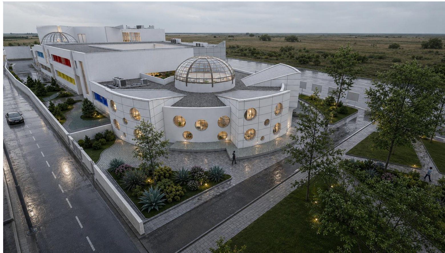
VUE SUR FAÇADES EST
