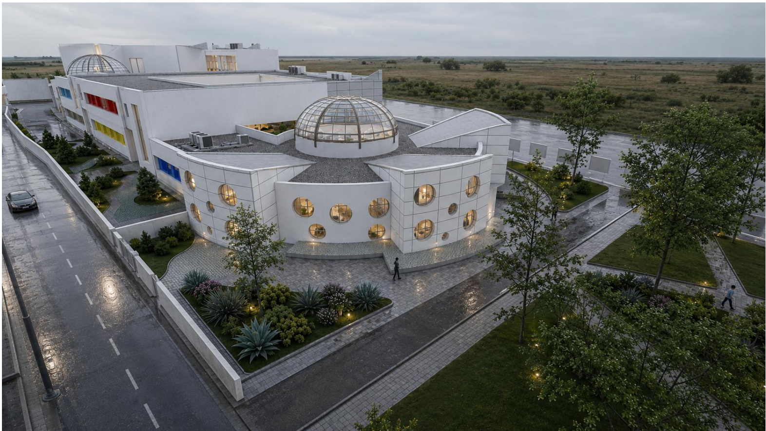
VUE SUR FAÇADES EST
