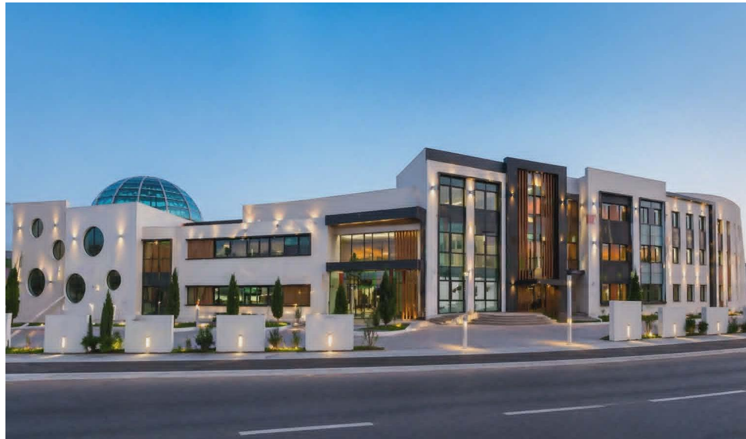
VUE SUR FAÇADES PRINCIPALE
