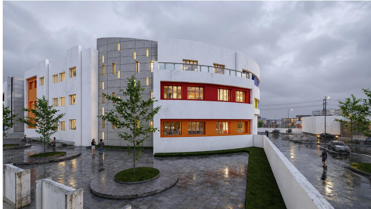
VUE SUR FAÇADES NORD EST
