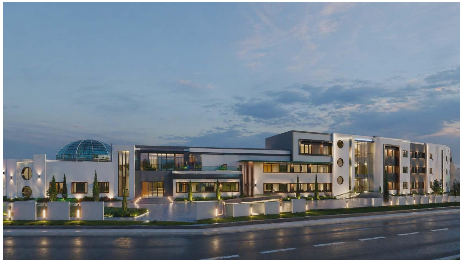
VUE SUR FAÇADES PRINCIPALE
