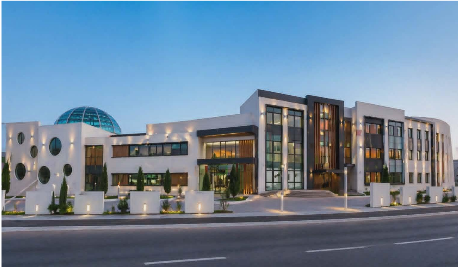
VUE SUR FAÇADES PRINCIPALE
