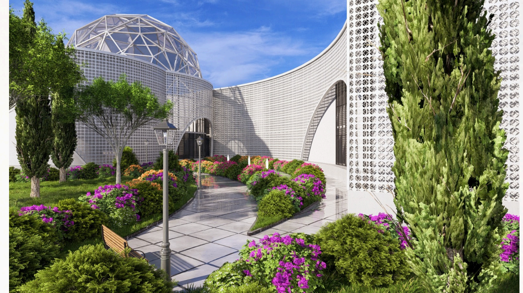
Le traitement extérieur des façades
