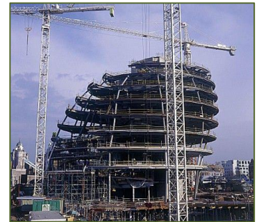
Figure 38 : Le bâtiment en construction source : https://issuu.com/luigidvf/docs/lch
