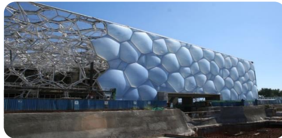
Fig82. Façade en cour de construction
