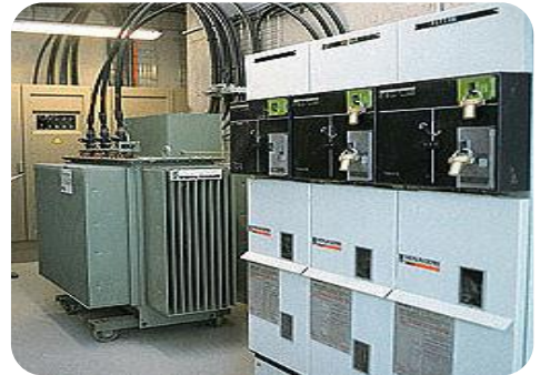
Fig247. Poste transformateur
