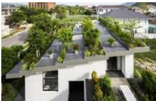
Figure 92 exemple d'une toiture vegetale
