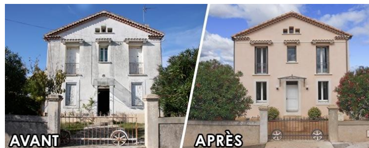
Figure 17 : Réparation de façades d'un immeuble résidentiel pour stopper les infiltrations et améliorer l'aspect; Source : https://www.camif-habitat.fr/renovation/maison/facade/
