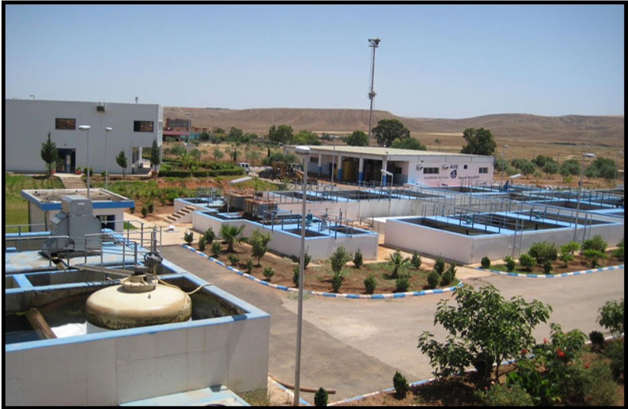
Figure 4 : photographie de vue de la station de Hammam Boughrara
