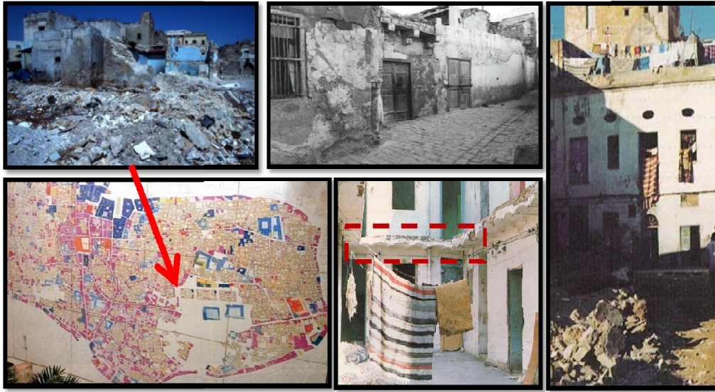
Figure 19: photos des problèmes du quartier El Hafsiya. 59
