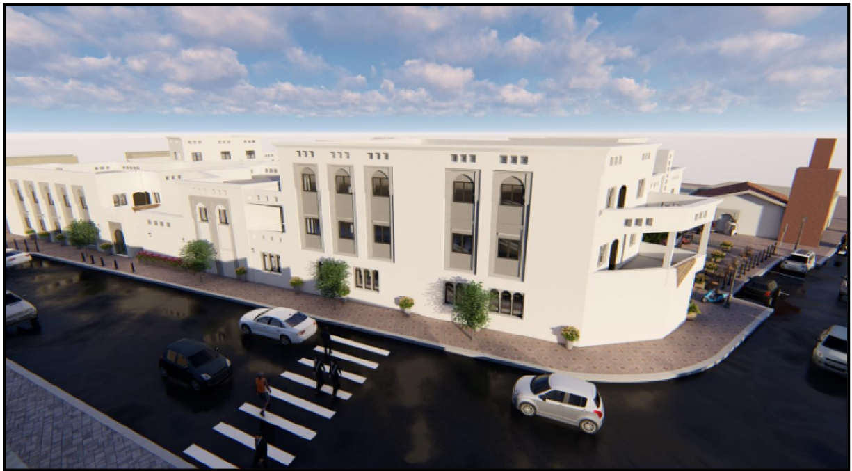
Figure 58: façade depuis le boulevard Gaouar Hocine.
