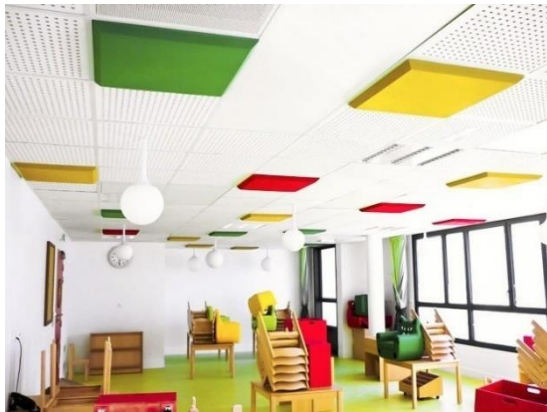
Figure 54 : Isolation phonique pour une salle de classe
