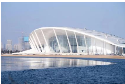
Figure 154: Centre de la Perle de l'OCS Source : https://architectureprize.com
