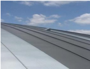
Figure 94 :Couverture en zinc Source : https://www.sifferlin.com
