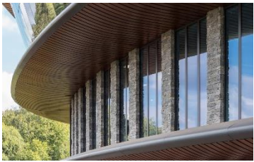
Figure 97 : Panneaux de pierre préfabriqués Source : https://find-an-architect.architecture.com/
