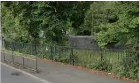
La clôture de l'école comme bord végétale
