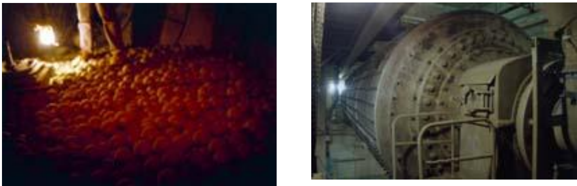
Figure 2.17 : Broyage du clinker.
