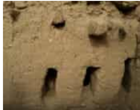
Figure 65 : ouvertures sur le patio (Source : Auteur 2023)
