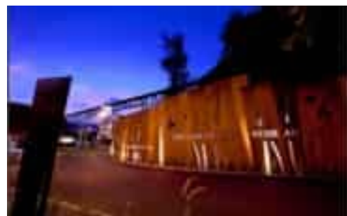
Figure 140 : l'éclairage nocturne (Source : Google image)
