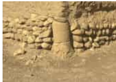
Figure 58 : Soubassement. (Source : auteur 2023)
