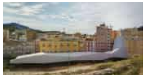
Figure 159 : vue sur la couverture (Source : Arch Daily)
