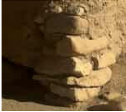
Figure 62 : mur extérieur d'une maison (Source : auteur 2023)
