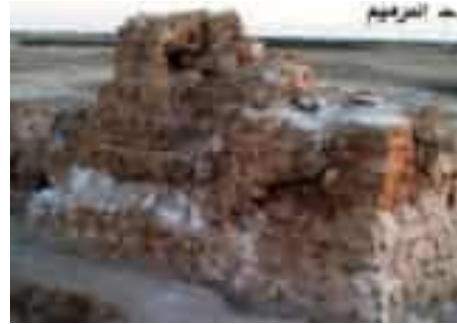
Figure 87 : Mur d'une salle des thermes après la restauration. (Source : Hadji, 2013)
