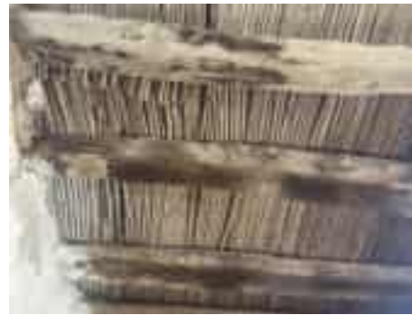
Figure 60 : Toiture avec des tiges de palmiers (source : auteur 2023)
