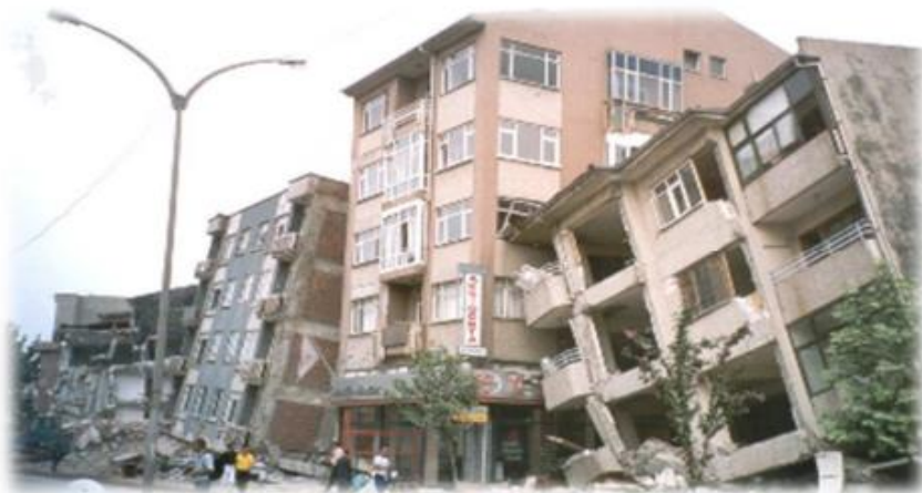
Figure 1-6: L'endommagement d'un bâtiment parasismique par des bâtiments non parasismique dans un centre urbain [3].
