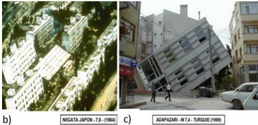
Figure 1-5: L'impact de la liquéfaction de sol sur les bâtiments. [3]
