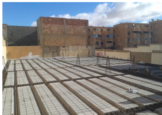
Figure VI. 03 : Plancher corps creux. Source : (Auteur).
