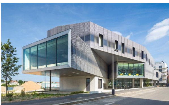
Figure III. 01 : Vue du projet.
