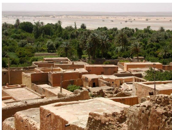
Figure IV. 13 : Ksar Tadjmout Source : (Auteur).
