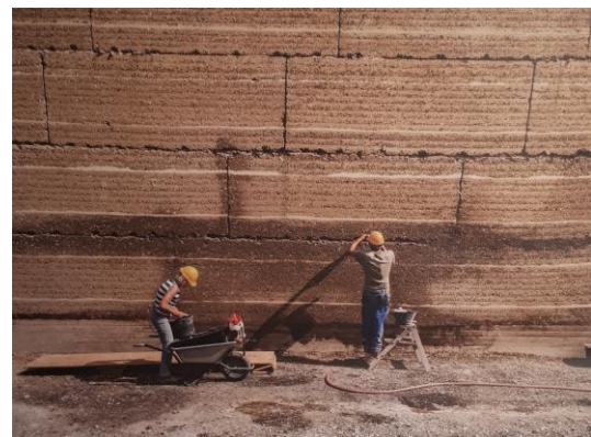
Figure VI. 02 : système de construction en BTS. Source : (Auteur).
