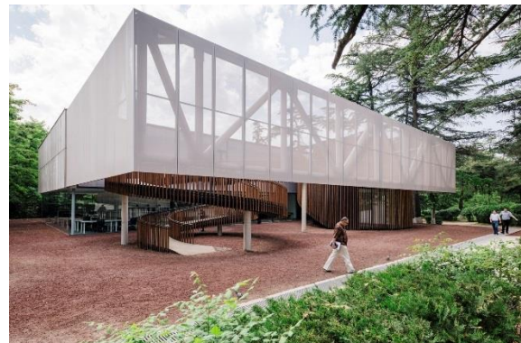
Figure III. 21 : Vue du projet.
