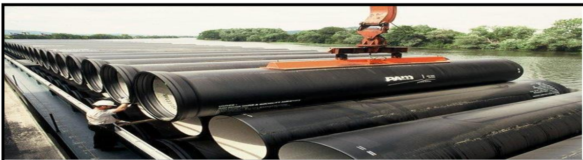
Figure I.5 Conduite en fonte
