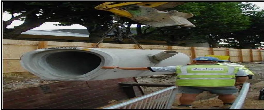
Figure I. 8 conduite ovoïde [15]
