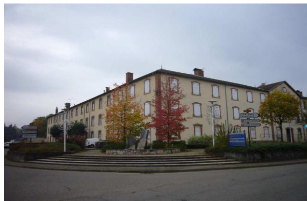
Figure. I. 12. L'usine en pisé à Saint Simeon de Bressieux dans l'Isère réhabilitée en logements. (Chabriac, 2014).
