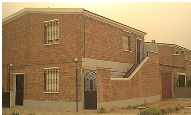
Figure. I. 7. Logements collectifs R+1 à Sidi Bel Abbès, Algérie. (Guettala ,2003)
