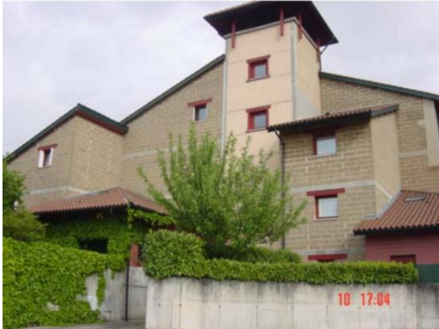
Figure. I. 16. Maison construite avec des BTC (dont la tour est en pisé) en RhôneAlpes, France. (Champire, 2017)
