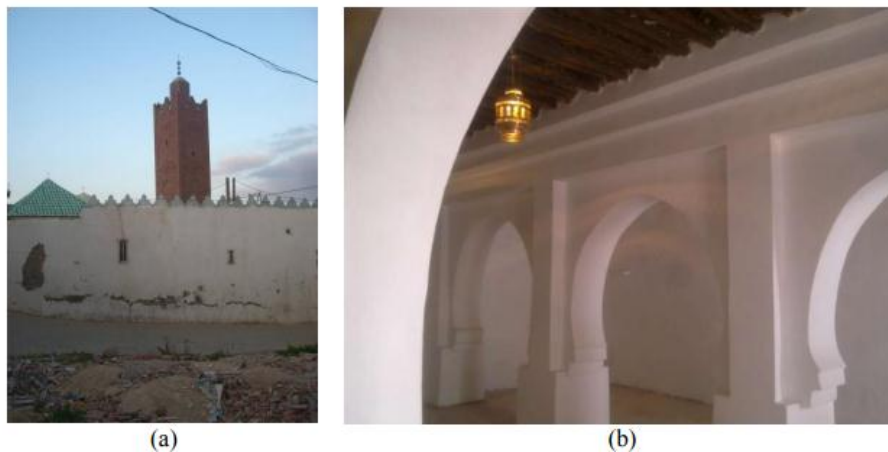
Figure. I. 9. Restauration de la mosquée Zahra à Béni-Snouss. Tlemcen. Avant (a) et après (b)(© Abdessemed-Foufa Amina, 2010)
