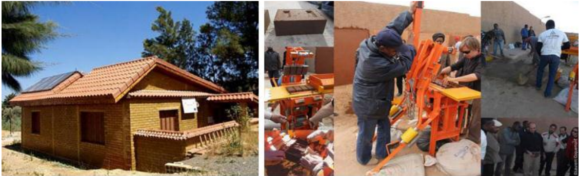
Figure. I. 8. Prototype d'une maison solaire réalisée par le CNERIB (a) (©www.cnerib.edu.dz, Le 14-05-2015); Atelier de formation sur les techniques de fabrication de BTC à Tamanrasset (b)(©prescriptor.info/.../cap-terre-des-ateliers-de-formation-sur-les-techniques, Le 14-05-2015) (Abdessemed-Foufa Amina, 2010)
