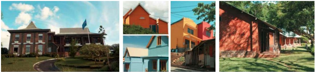
Figure. I. 15. Constructions en BTC à Mayotte : Préfecture ; Logements sociaux, Ecole. (Source : craterre.org )
