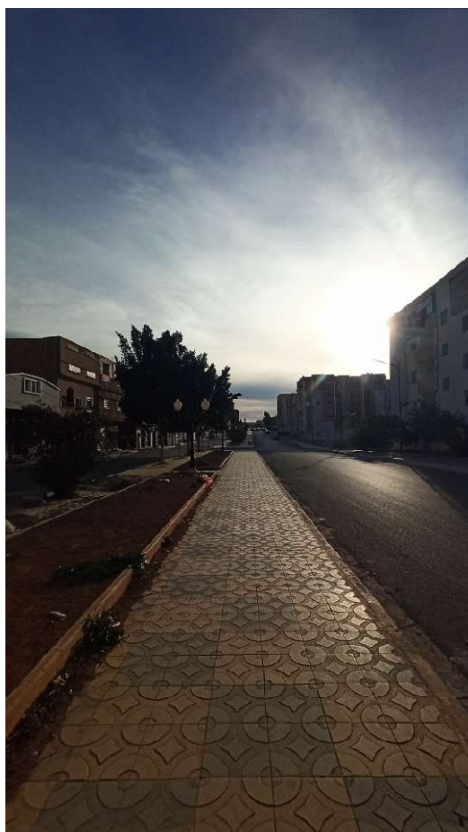
Figure 80 : La voie principale
