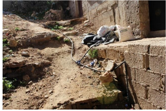
Fig. 21 : Enchevêtrement Anarchique et apparent des Connexions d'Eau
