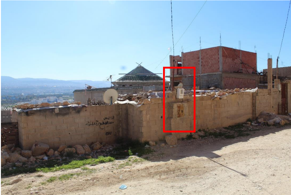
Fig. 18 : Baraque avec toiture en matériaux de récupération, équipée de gaz et d'électricité
