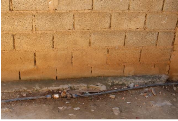
Fig. 21 : Enchevêtrement Anarchique et apparent des Connexions d'Eau
