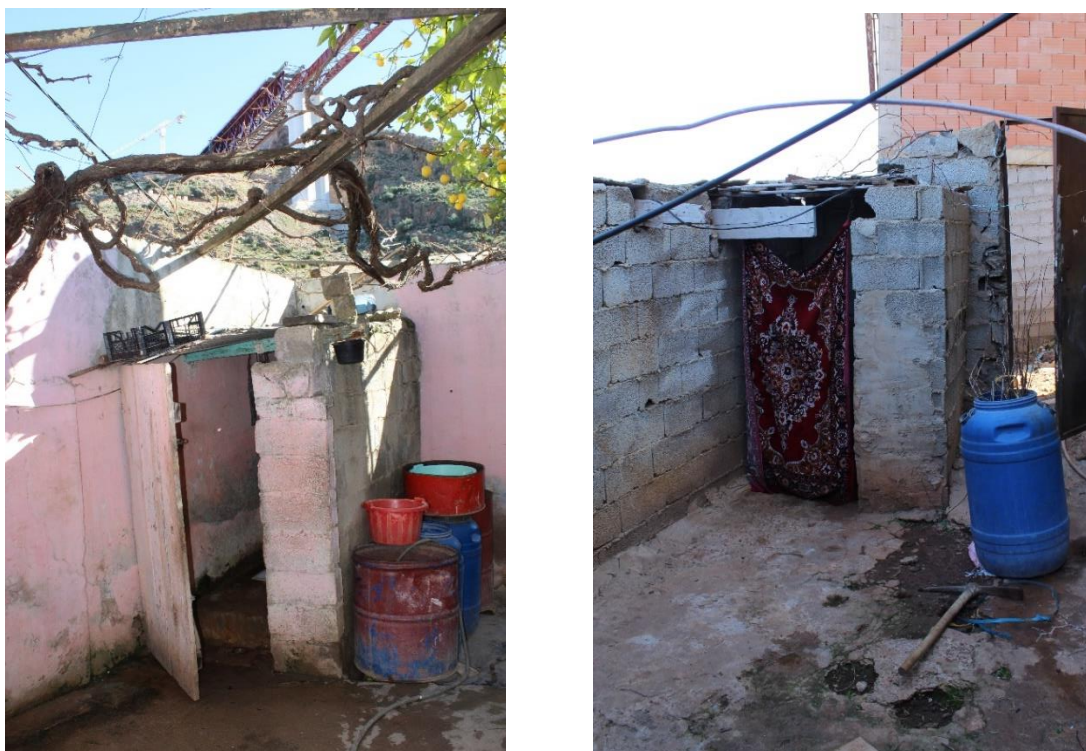
Fig. 23 : Sanitaires extérieurs couvert avec matériaux de récupération
