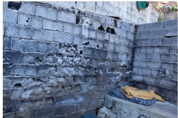
Fig. 19 : Illustration des dommages résultant d'incendies attribués à des connexions électriques inappropriées
