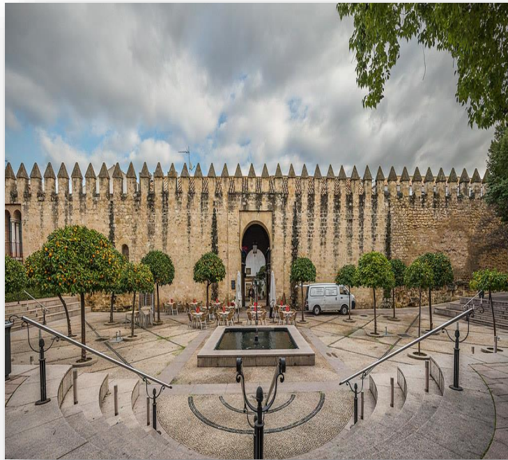
Figura 7. Puerta del Puente
