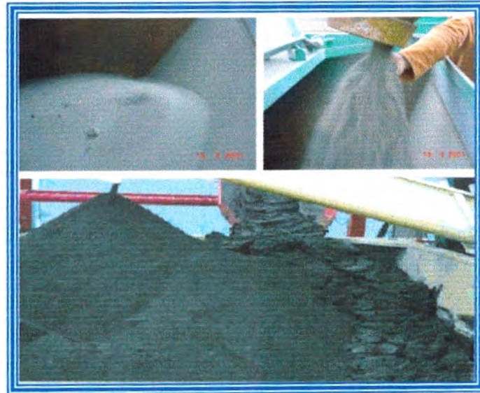
Photo n°08 : Etat des déblais, après traitement.
