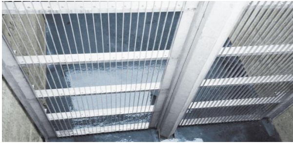
Figure I.4 : Dégrillage grossier [25]
