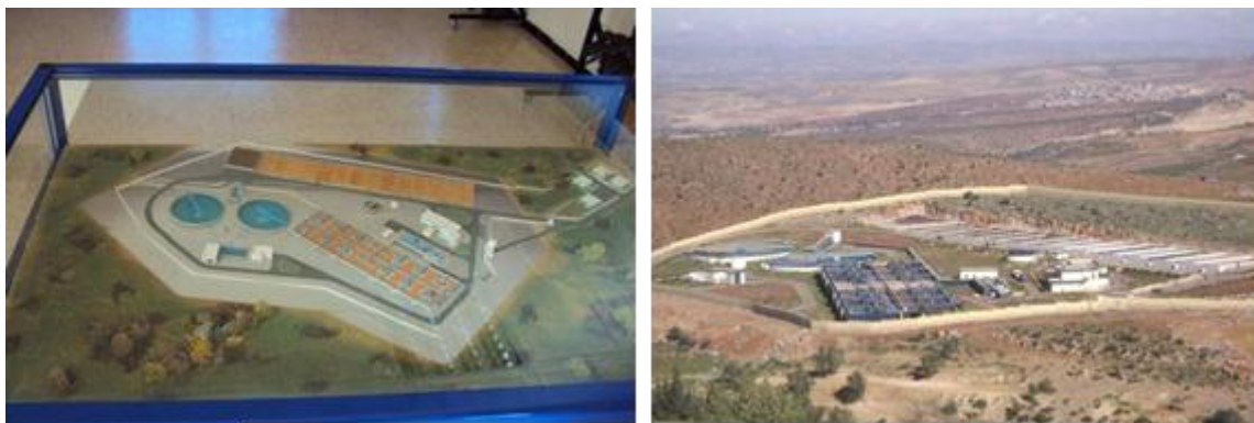
Figure III.1 : Vue générale de la station d'épuration ONA – Tlemcen
