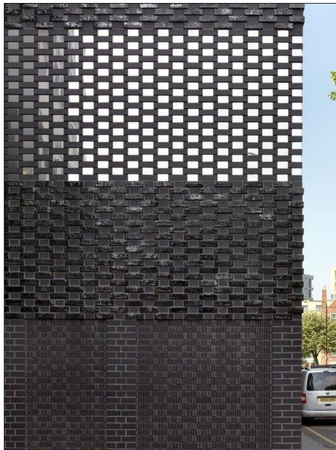
Figure 119: Traitement en moucharabieh par l'utilisation de la brique
