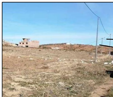
Figure 90 : Les poteaux électriques se situent en périphérie du terrain. Source : Auteur
