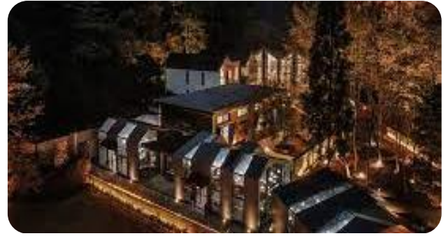
Figure 36 : Chengdu Dayi 1979 Plant Boutique Hôtel /OAD
