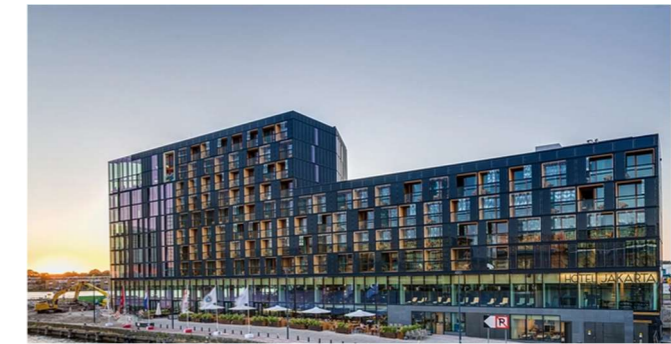
Figure 133 : façade exemple 06 Source : www.archdaily.com
