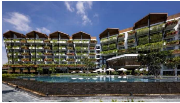
Figure 134 : façade exemple 04 Source : www.archdaily.com
