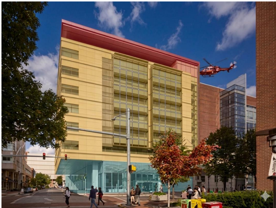
Figure 08 : Façade principale et accès de la Shock Trauma Tower.
