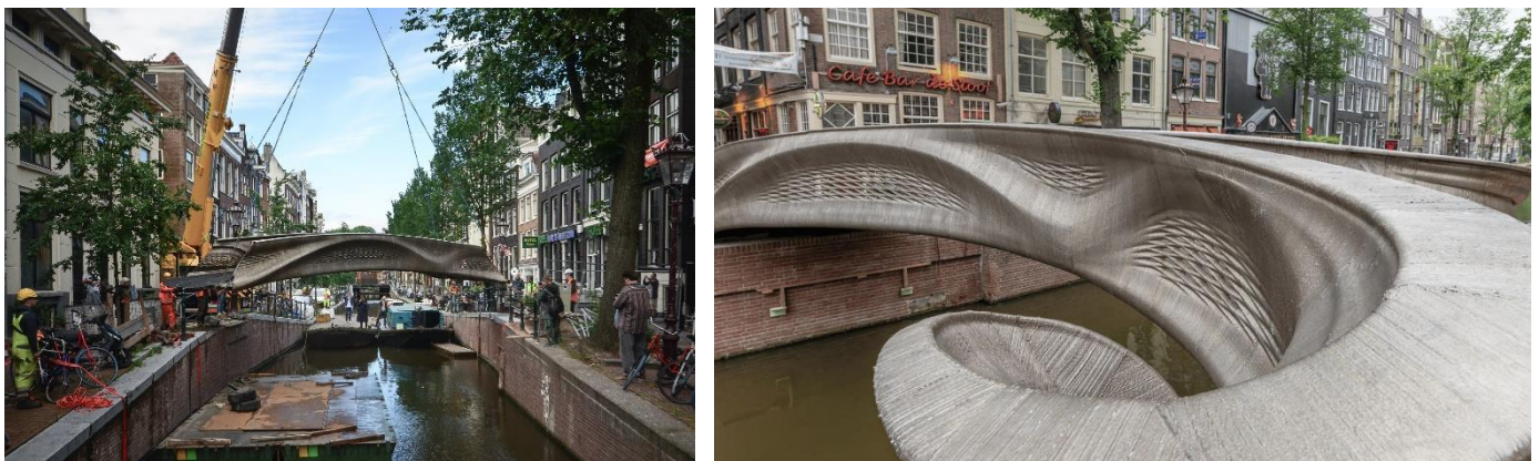
Figure 36 : Pont MX3D Amsterdam — conception générative et impression 3D en acier
