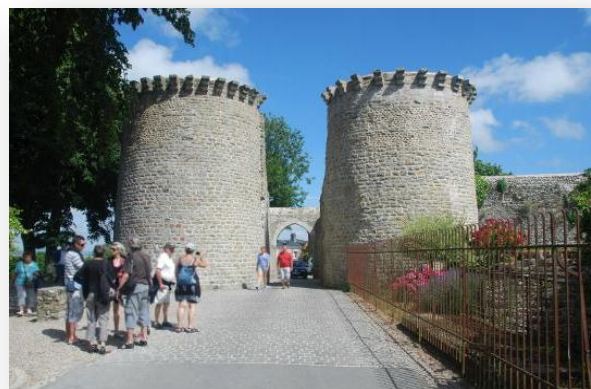
Figure 7. la tour du Saint- Valery-sur-somme (France) 24
