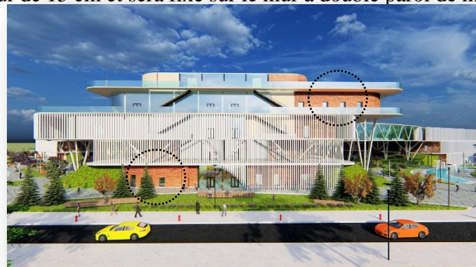
Figure 73. Le mur pisé sur la façade.
