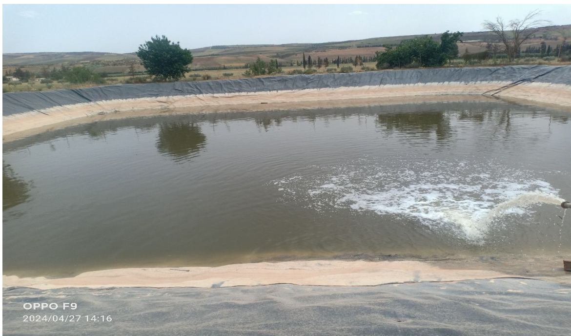
Figure I. 4: Bassin géomembrane.
