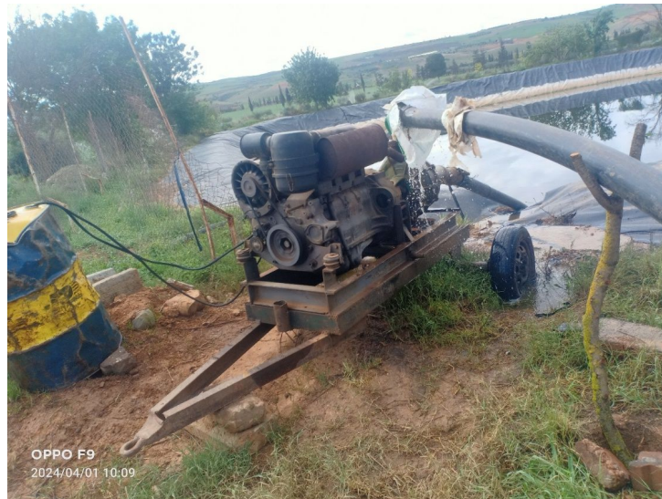
Figure I. 5: Moteur diesel dans la deuxième station de pompage.
