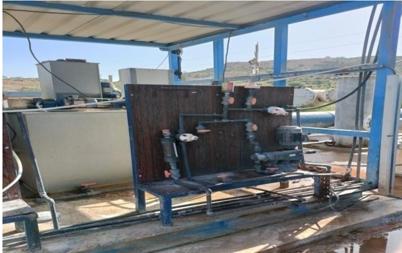
Photo 5: L'injection de polymère (Tlemcen le 09-04-2025)
