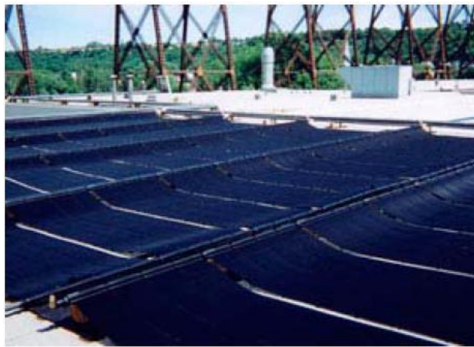
Figure I.6 : Capteur solaire non-vitré [7]
