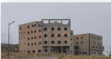
Figure 98 : bati en construction
