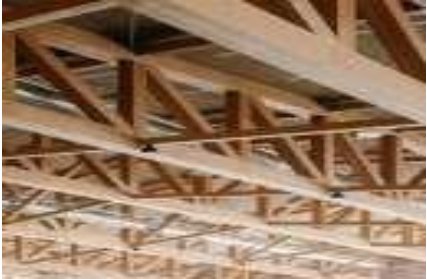
Figure 74 : Détail de la charpente Source : epa-paris-saclay.fr
