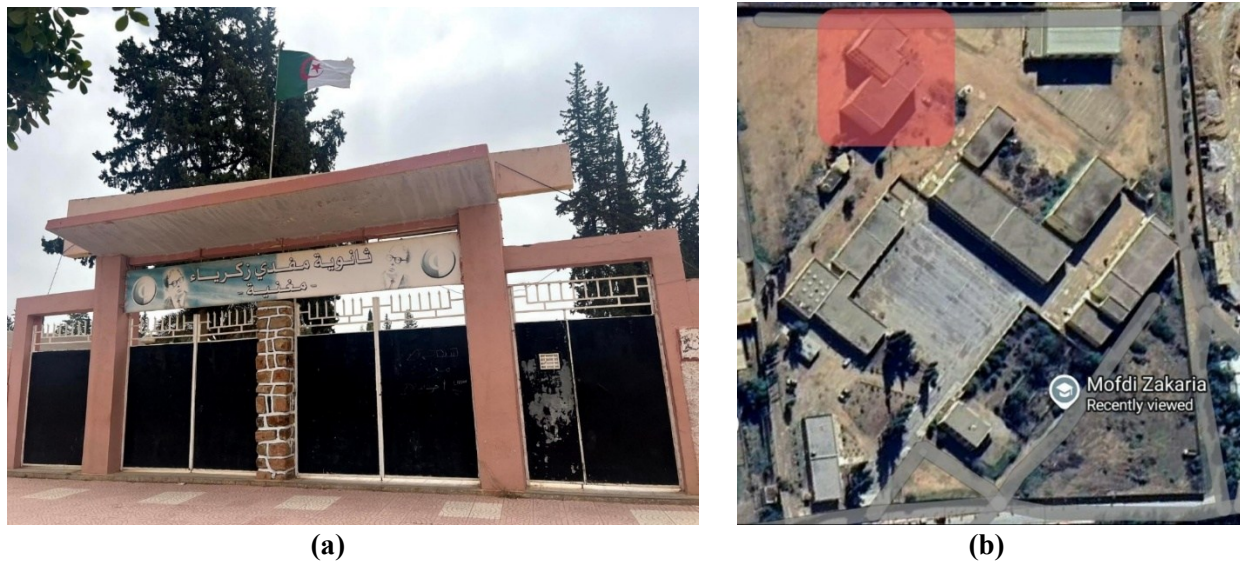
Figure IV.9. (a) Façade principale du lycée Moufdi Zakaria (b) Position de bloc étudié
