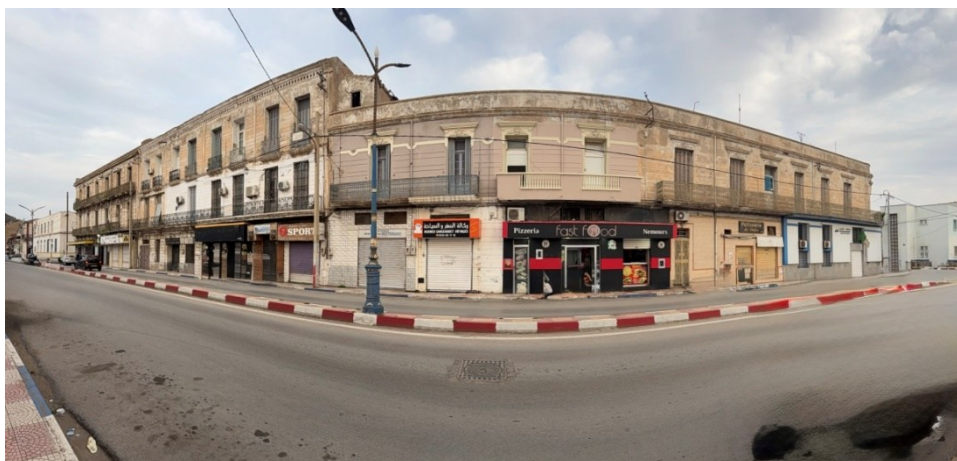
Figure IV.1. Vue générale du bâtiment étudié sur le front maritime de Ghazaouet
