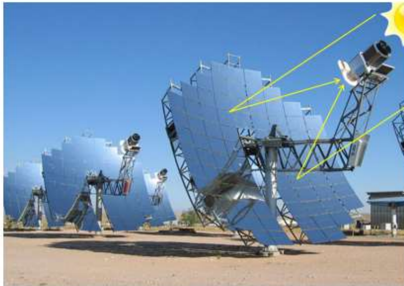
Figure I-7 : Concentrateur parabolique [18]
