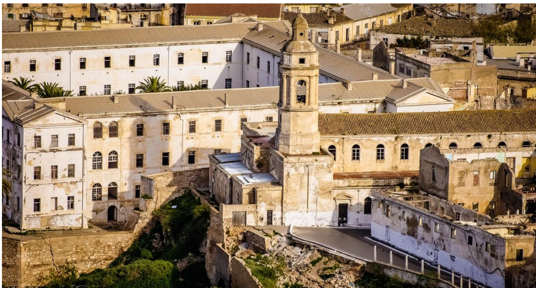
Figure 91 vue d'ensemble des bâtiments
