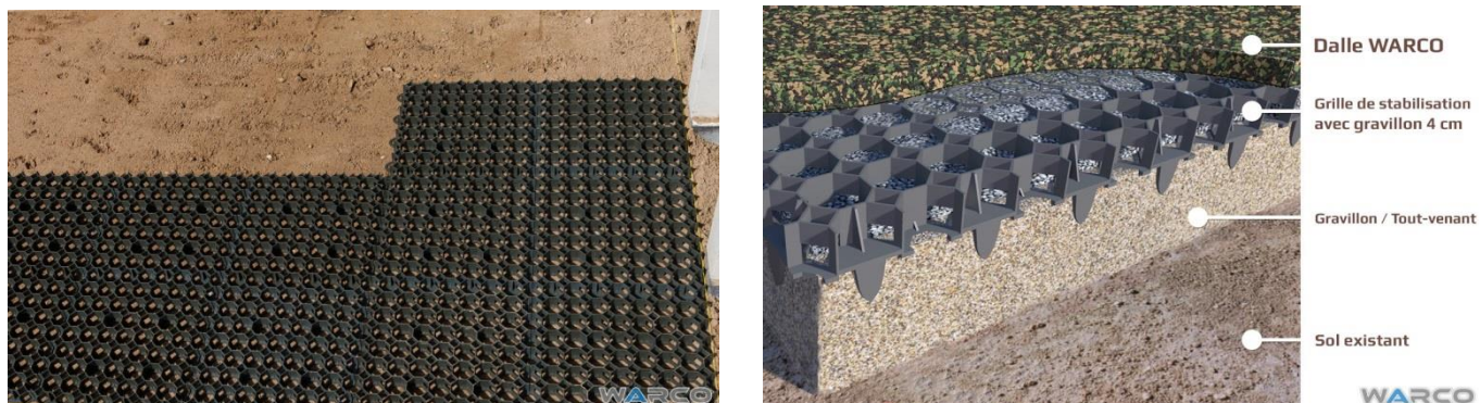
Figure 135 pose d'une grille de stabilisation
