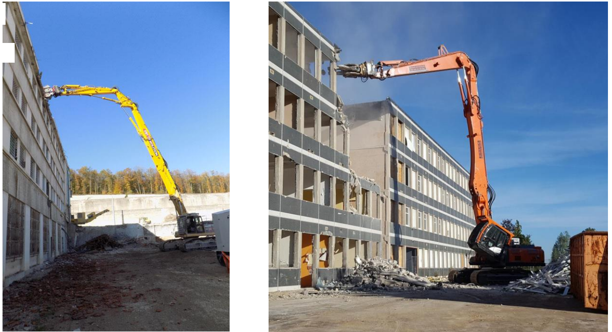
Figure 131 exemple démolition par découpage partiel d'une structure
