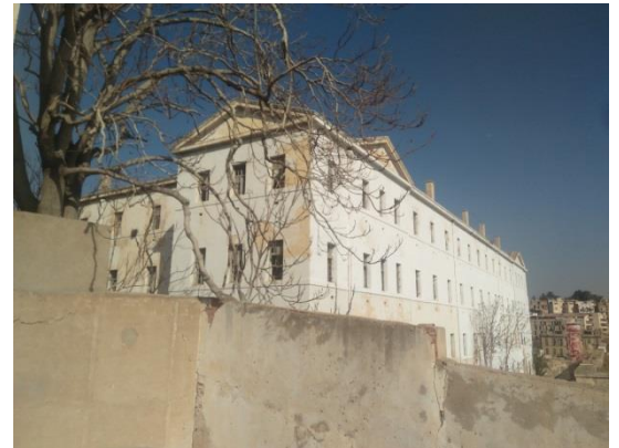
Figure 86 vue sur la façade Est
