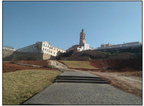
Figure 81 avancement des trvaux de la promenade 14/02/2019
