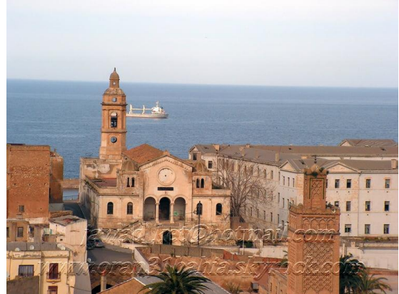
Figure 92 façade principale de l'église
