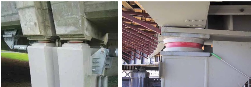
Figure I-14 : Isolateurs à pendule de friction (FPS) [7].
