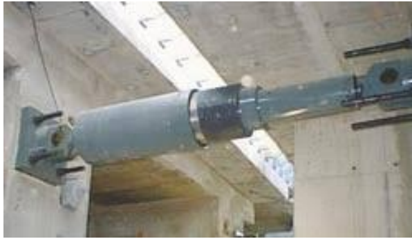
Figure I-15 : Amortisseurs visqueux [9].
