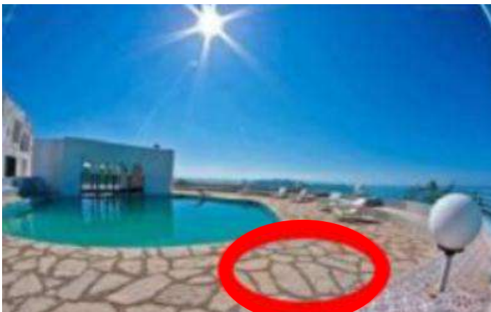
Figure 40: Traitement de sol en pierre
