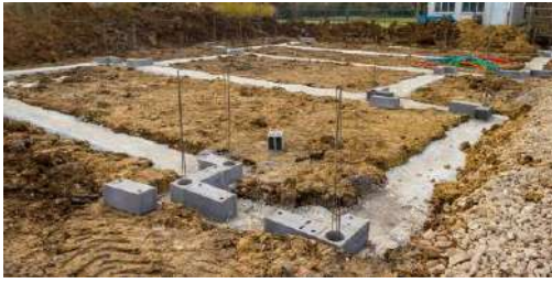
Figure 99: semelle filante en BA
