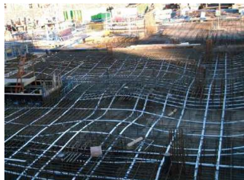
Figure 101: une dalle Précontrainte par post-tension
