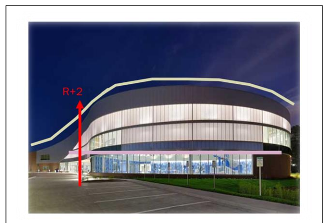
Figure 29 : Façade nord montrant l'accès principal Source : Archdaily.com traitée par l'auteur
