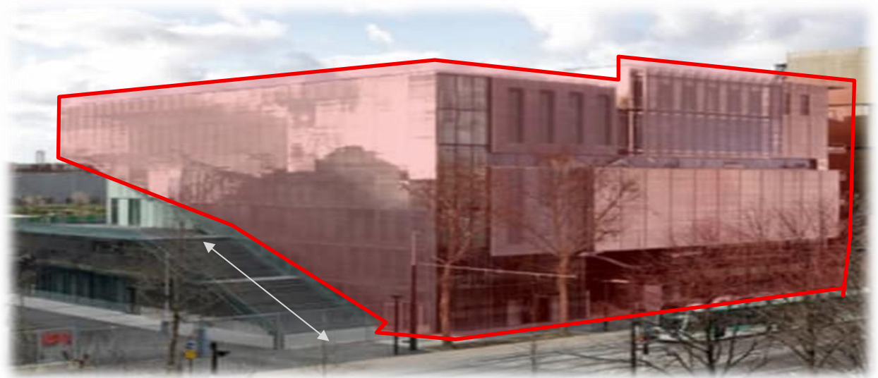
Figure 8 : Façade nord montrant l'accès principal par escaliers
