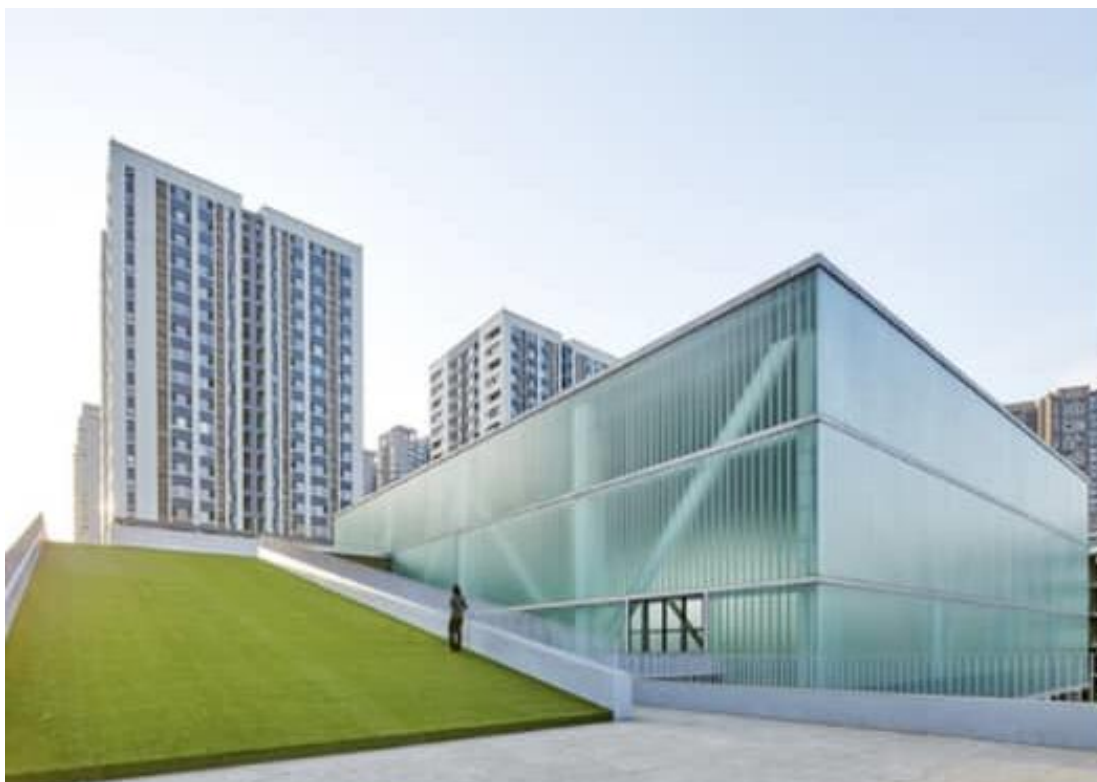
Figure 49 : façade principale montrant l'espace extérieur du centre
