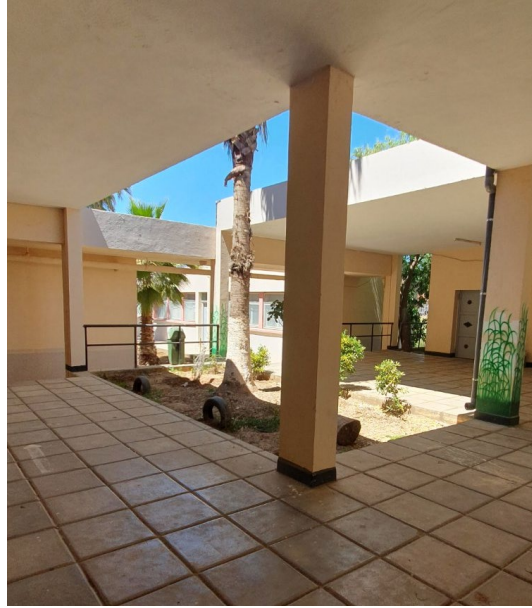
Figure 57 : structure existante de l'institut
