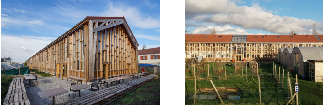
Figure 36: Le bâtiment Résilience et les serres pédagogiques. 66
