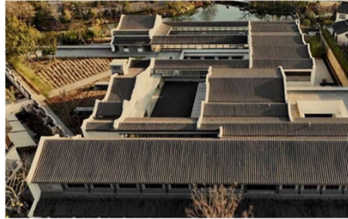
Figure 105: Toiture du projet
