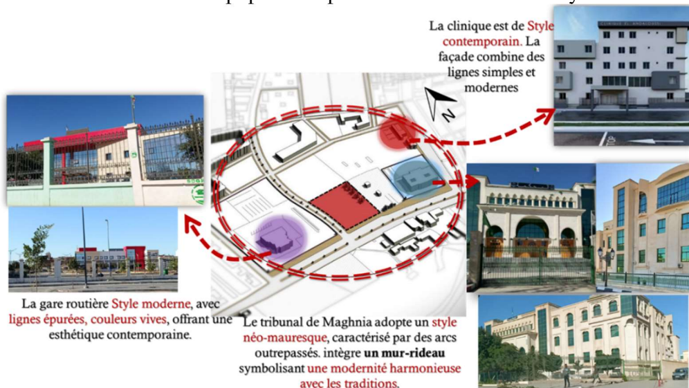
Figure 139: Environnement immédiat. Source : Auteur
