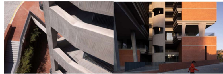
Figure 61: L'utilisation de béton brut Source : https://www.archdaily.com/
