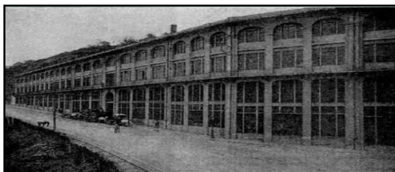
Figure 10: Les usines BASTOS d'Oran (façade principale) 61
