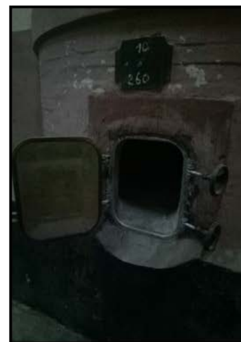
Ouverture numérotée d'une cuve
