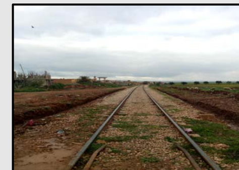
Figure 42: Voie ferré non clôturée 140
