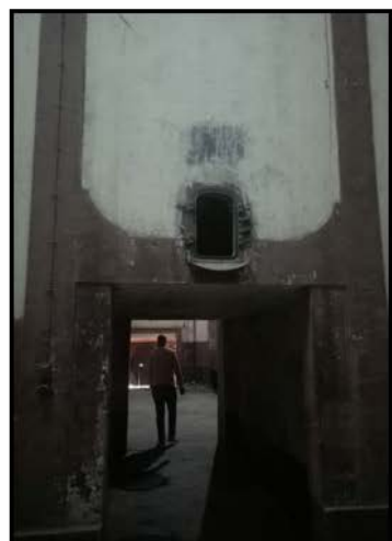
Passage sous les cuves
