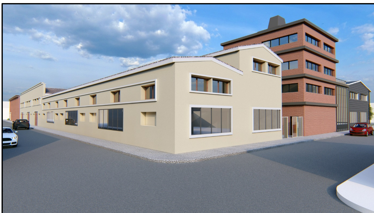
Vues depuis la Rue Benachir Messaoud
