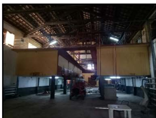
Cuves supportées avec des poteaux de 1.5 m
