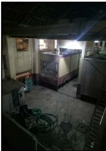
Cuves Supportées par des poteaux de 50 cm
