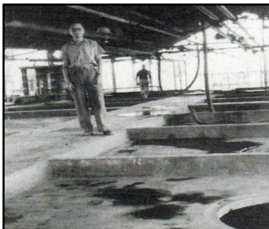
Figure 29: Sur le haut des cuves à la cave CARREGA 123
