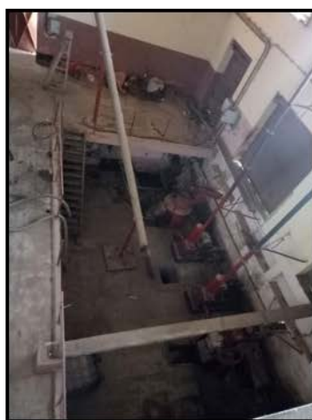
Vue sur sous-sol
