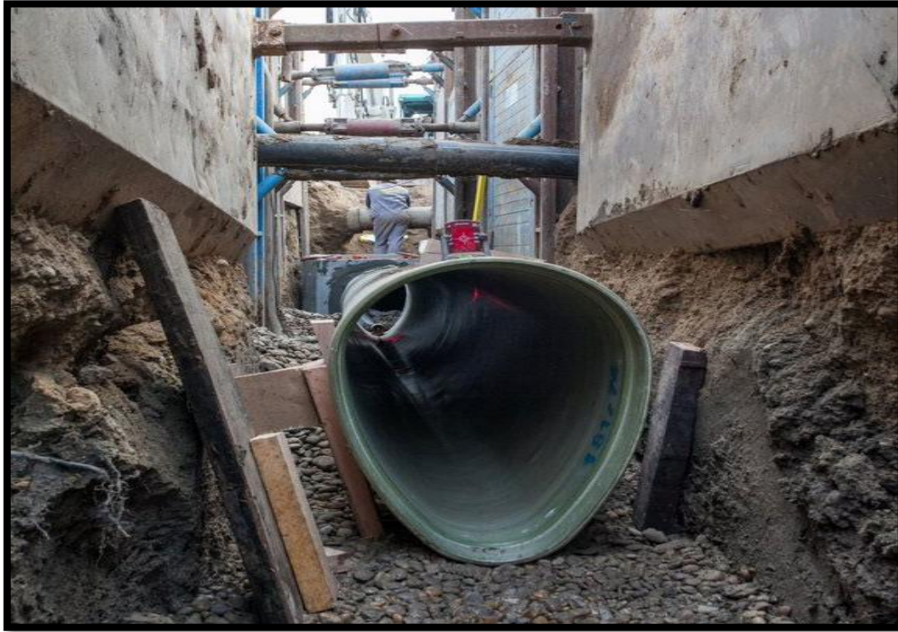
Figure I.21 : conduite coque ovoïde [26]
