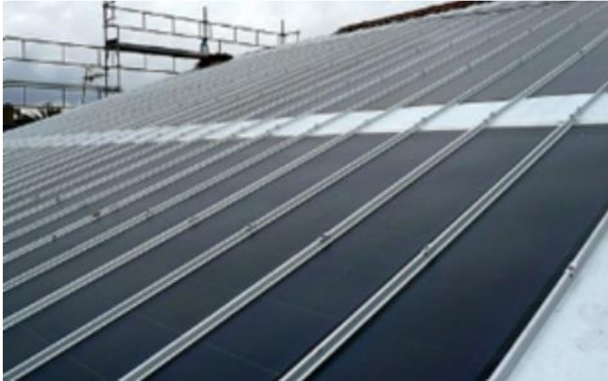
Figure II.21: Vu d'un capteur solaire non vitré [36]
