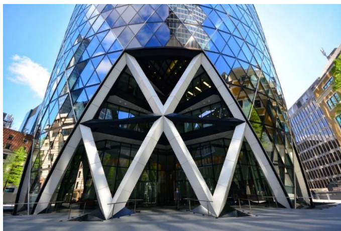
Figure n° 58: Diagrid de 30 St Mary Axe par Norman Foster.
