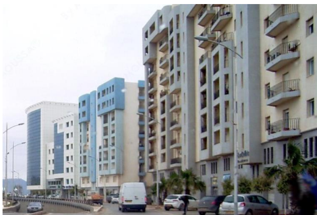
Figure n° 46: Immeuble d'habitat collectif (partie Sud)
