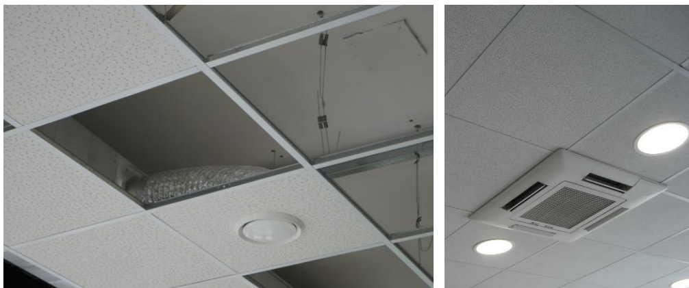
Figure n° 73: Passage des équipements au-dessus du plafond.
