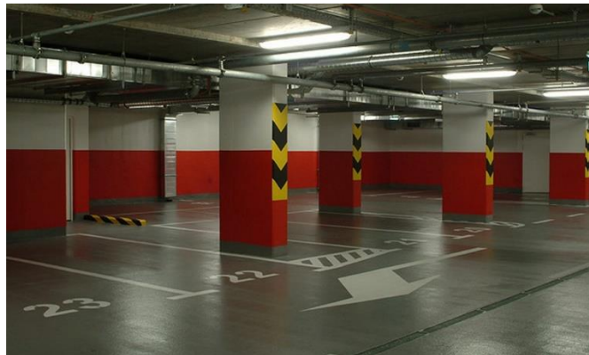
Figure n° 108: Marquage au sol pour parking.
