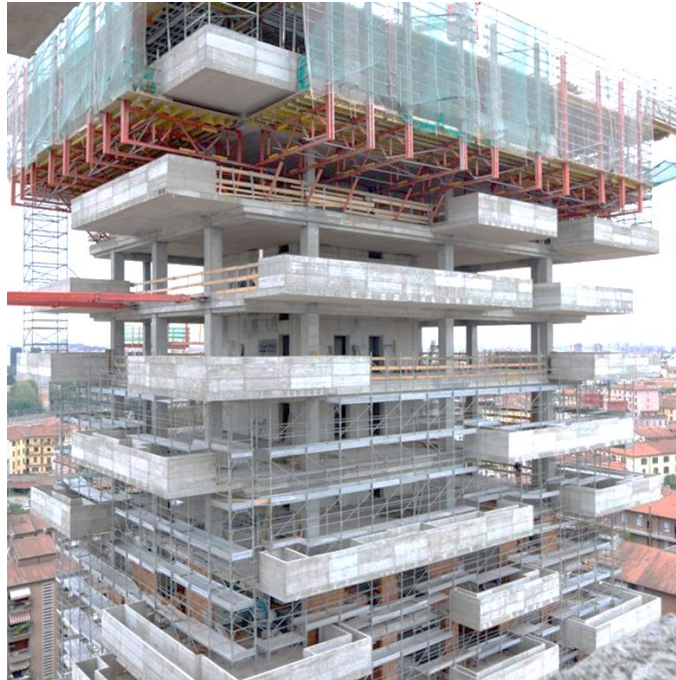
Figure n° 08: Image montrant la structure des balcons destinés à la végétation.
