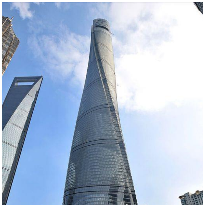
Figure n° 78: La tour torsadée de Shanghai.
