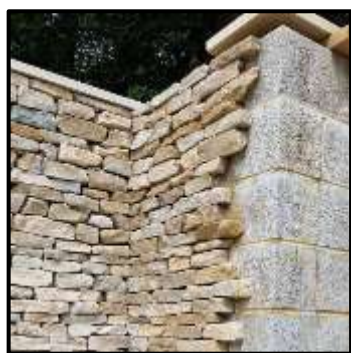
Photo 35 : Revêtement en pierre (source : https://pin.it/5AGG9viIx )
