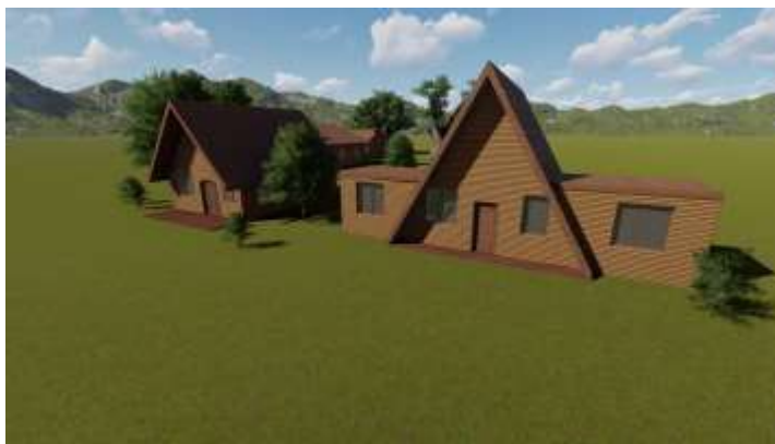
Figure 35: Les toits inclinés des chalets (source: auteurs)
