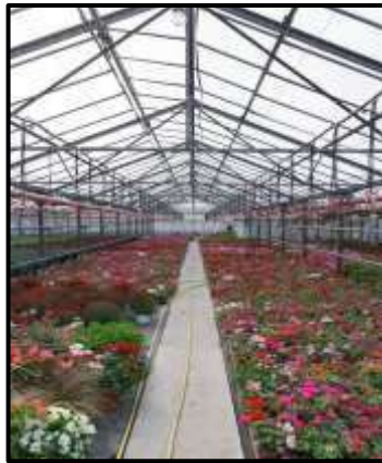
Photo 37 : Serre bioclimatique (source : Wikipédia)
