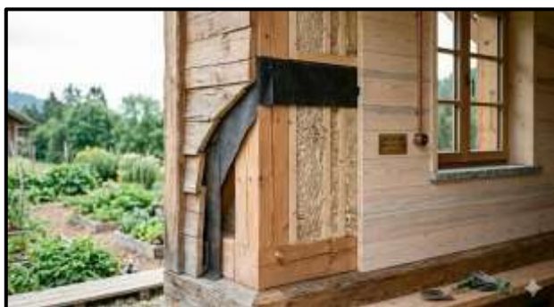
Figure 66 : mur en bois (source : les auteurs)
