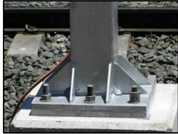
Photo 34 : semelle avec poteau en métal (source : https://pin.it/2Fj8DcZrf )
