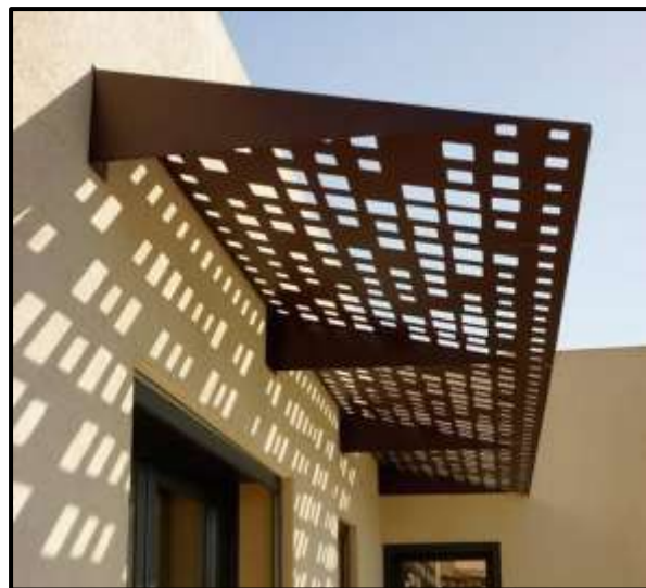
Figure 72 : Fenêtre avec brise-soleil (source : https://pin.it/5r2zVINjL )
