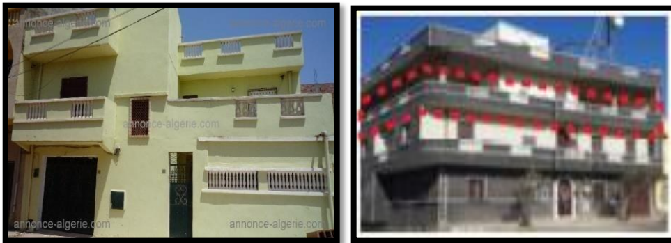
Figure 97: des maison post colonial
