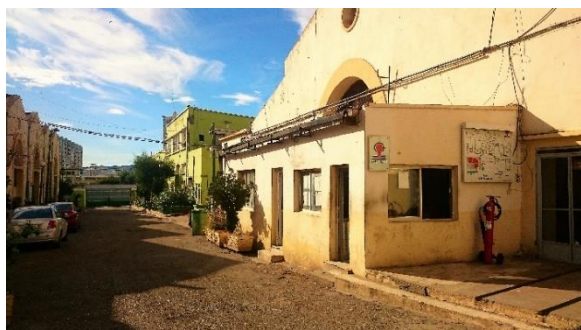
Fig 70 : photo depuis l'entrée principale vers l'unité magasin
