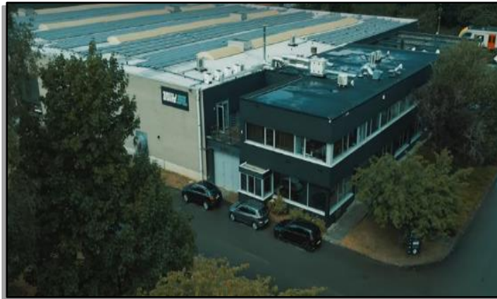
Figure 88 : Façade Source 15 : Auteur
